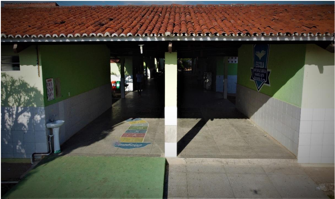
Figura 23 - Vista da entrada
