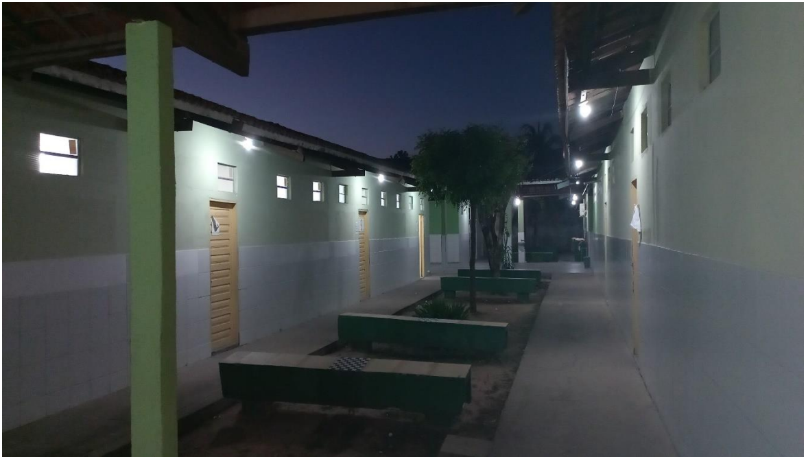
Figura 25 - Vista corredor interno das salas de aula
