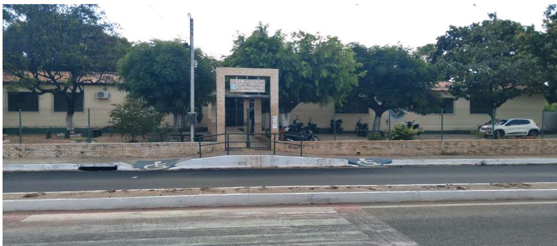
Figura 4: Fachada da Escola
