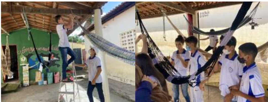
Figura 10 - Montagem das Instalações.
