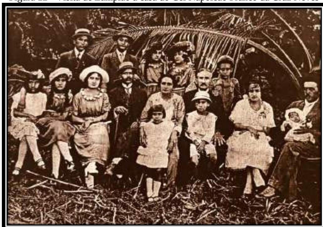
Figura 12 - Visita de Lampião a casa do Cel Napoleão Franco da Cruz Neves
