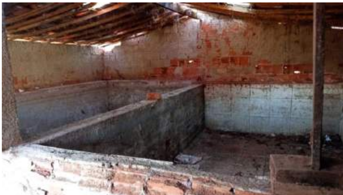
Figura 10 – Tanques de concreto da salgadeira de Brejo Santo/CE
