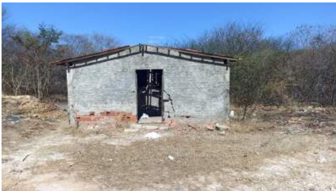
Figura 8 - Antigas instalações da salgadeira de Brejo Santo/CE
