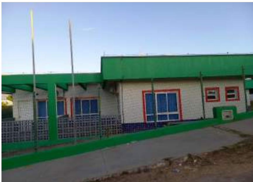
Figura 4 - Fachada do Centro de Educação Infantil Martinho Tavares Teles
