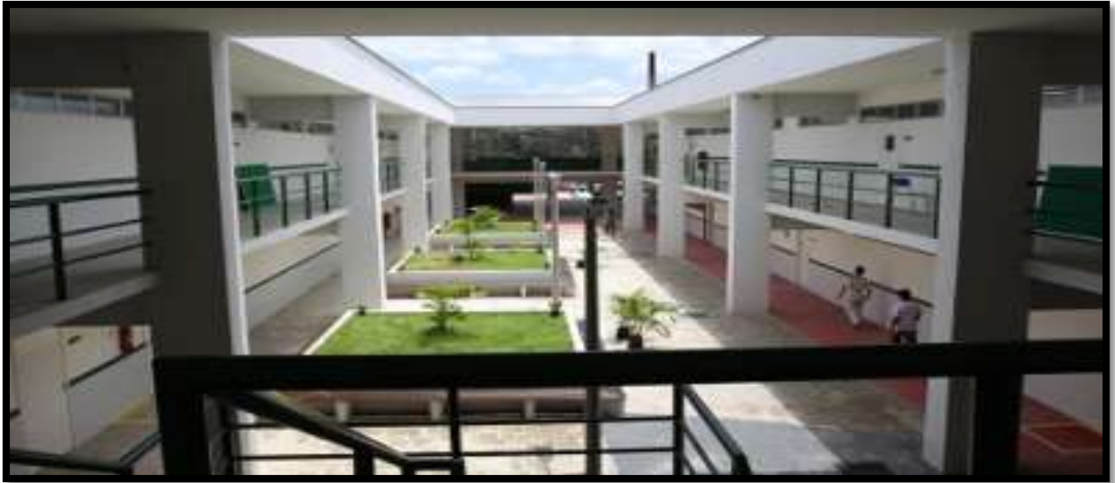
Foto: Pátio localizado no térreo da escola que dá acesso aos laboratórios, sala dos professores e salas referente a gestão. Primeiro andar, onde ficam localizadas as salas de aulas. (Elaborada pelo autor)
