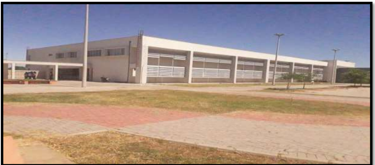
Foto: Parte externa do prédio referente as salas de aulas, laboratórios da base comum, banheiros, gestão, secretaria, biblioteca e auditório. (Elaborada pelo autor)
