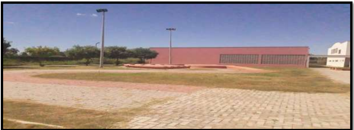
Foto: Prédio onde estão os laboratórios especiais da base técnica. (Elaborada pelo autor)
