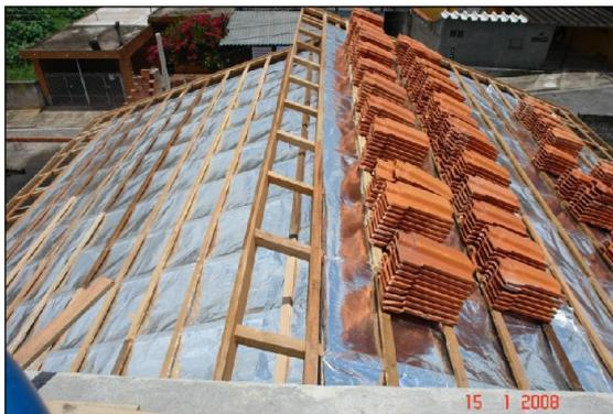
**Figura 8** – Exemplo de manta térmica.
