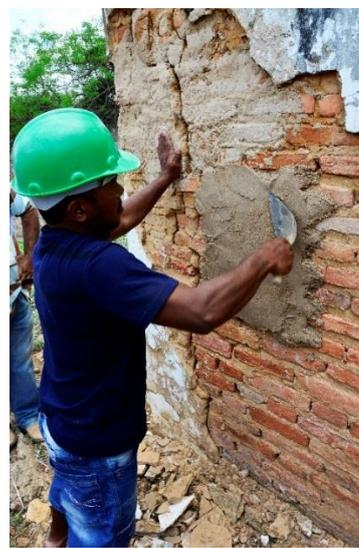
Figura 52 – Aplicação de argamassa no muro
