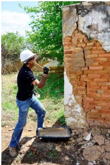
Figura 51 – Aplicação de chapisco no muro
