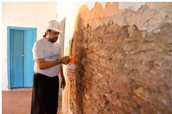
Figura 47 – Pulverização de leite de cal
