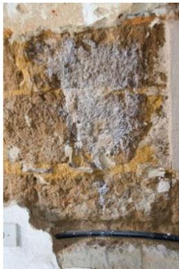
Figura 49 – Pulverização de leite de cal
