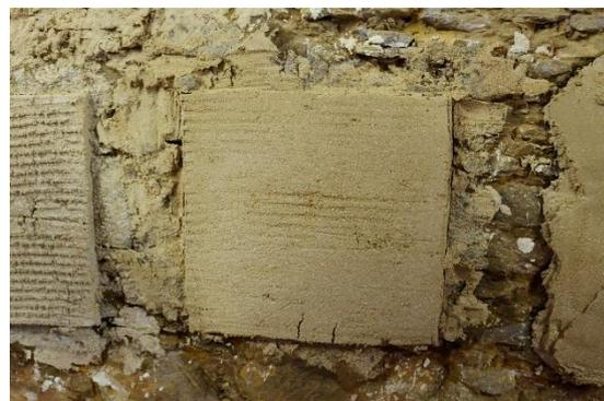
Figura 48 – Argamassa assentada em parede de pedra
