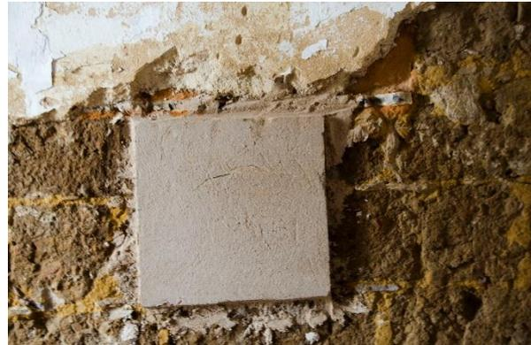
Figura 50 – Argamassa em parede de adobe
