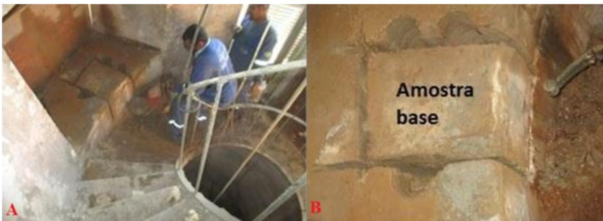
**Figura 5** – Processo de Retirada da Amostra da Alvenaria na Torre Epístola. Fonte: Sobrinho, 2016.
