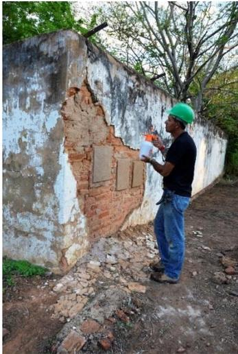
Figura 53 – Umedecimento no muro
