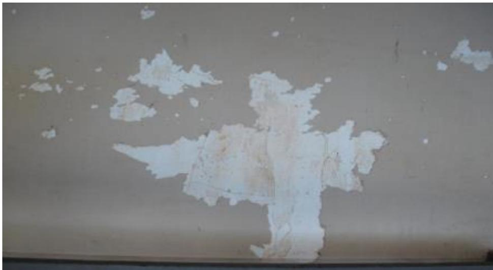
**Figura 5** – Descascamento de pintura
