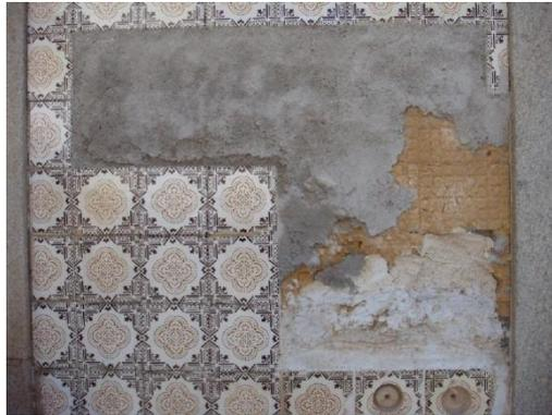
**Figura 2** – Uso inadequado de argamassa de cimento em fachada de azulejos em Ovar, Portugal
