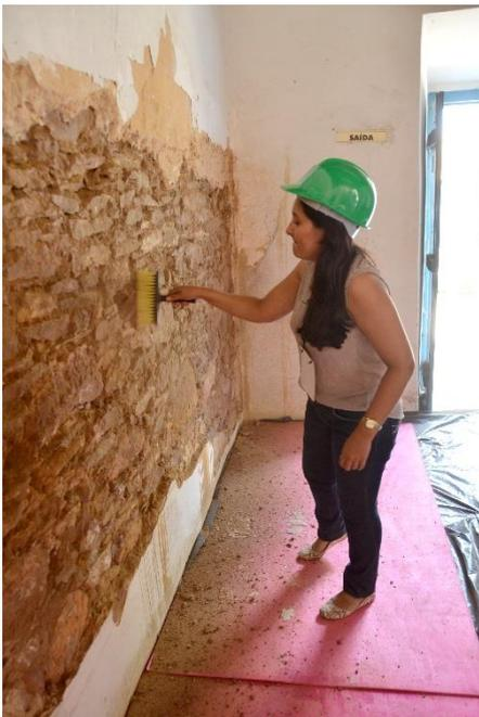
Figura 45 – Limpeza de resíduos superficiais na parede
