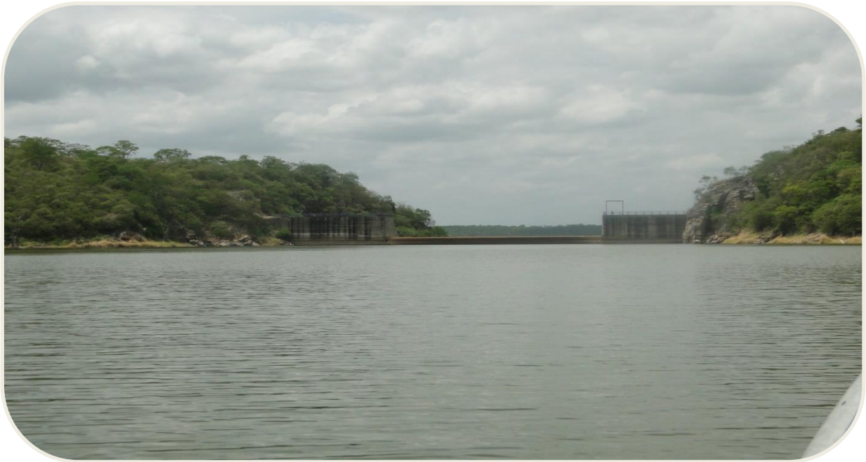
Figura 3. Vista parcial do Reservatório Canoas, Assaré, CE, março de 2017.
