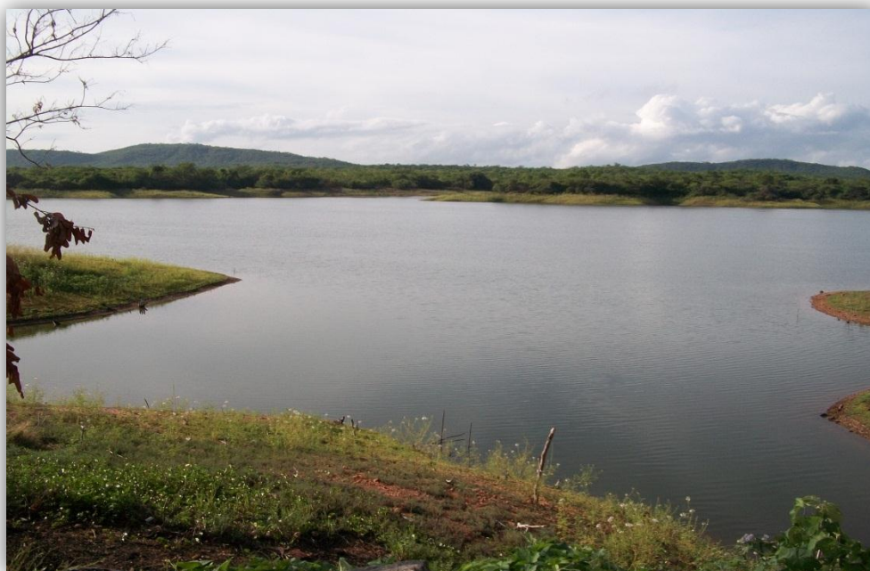
Figura 2: Vista parcial do reservatório Rosário.
