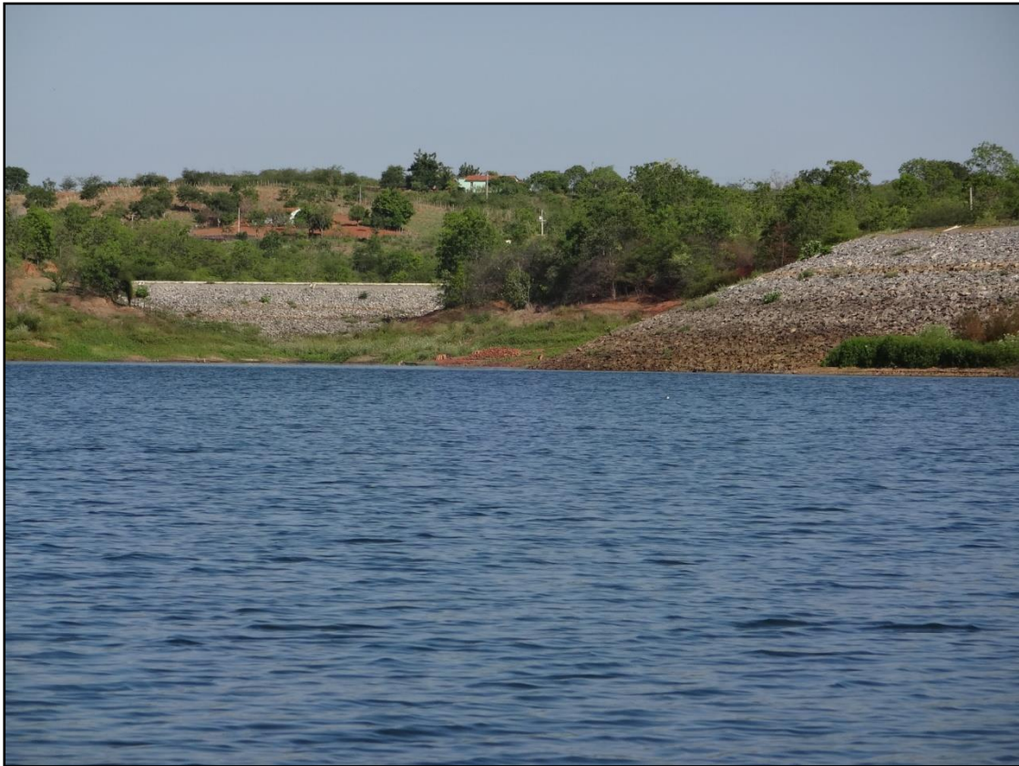
Figura 1 – Vista parcial do Reservatório Cachoeira, Aurora, Ceará.
