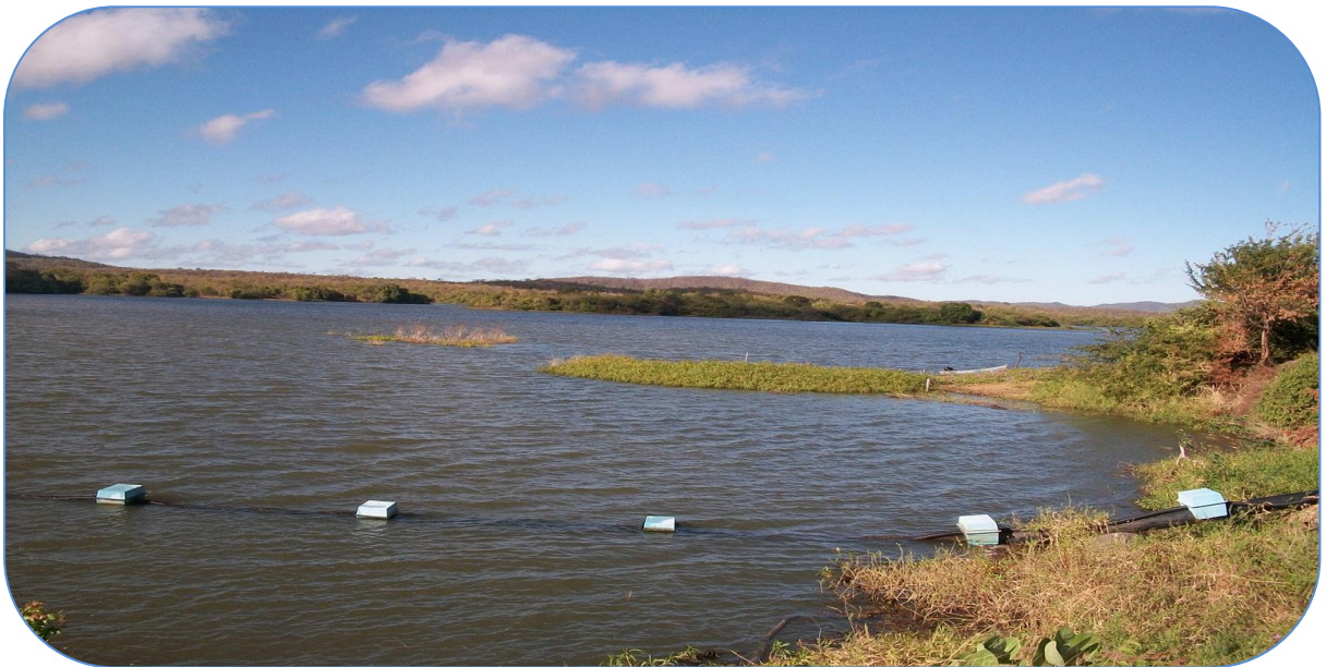
Figura 1. Vista parcial do Reservatório Rosário, Lavras da Mangabeira, CE.
