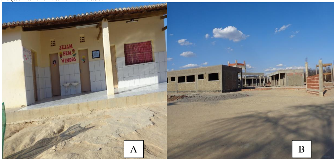
Fig. 4: A: Escola de Ensino Infantil da Comunidade Quilombola, B: Escola de Ensino Fundamental em Construção na referida comunidade.
