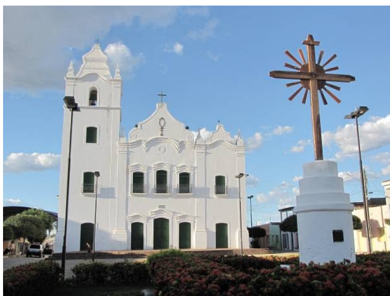
Imagem 30: Fotografia da Igreja do Rosário – Icó/CE
