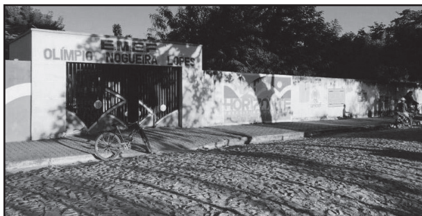
Figura 24 - Escola Municipal Quilombola Olímpio Nogueira Lopes (área externa)
