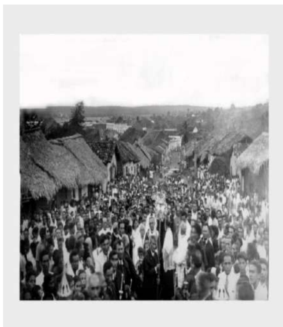
Figura 3 – Casa de taipa com telhado de palha, na sede de Crato nos anos 20.
